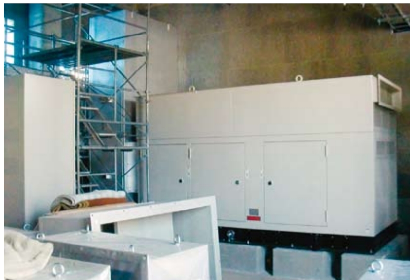
◀ 非常用発電設備 搬入据付状況
