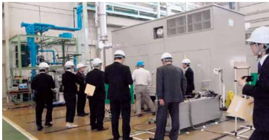
▲工場検査（ガスコージェネレーション） ヤンマー岡山工場にて性能試験を実施
