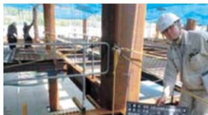
③鉄骨建て方検査
