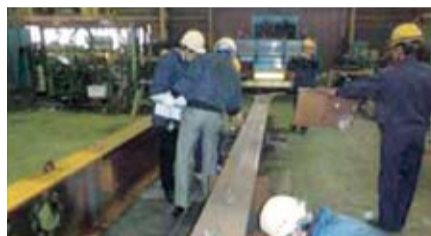
①鉄骨工場検査
