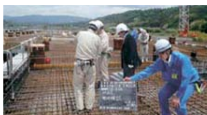
④床配筋検査
