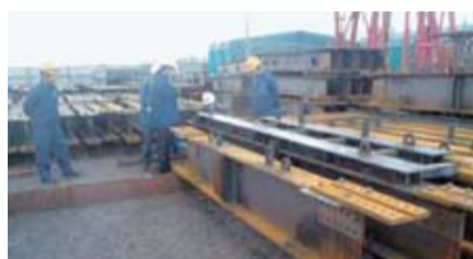
②鉄骨現場受け入れ検査
